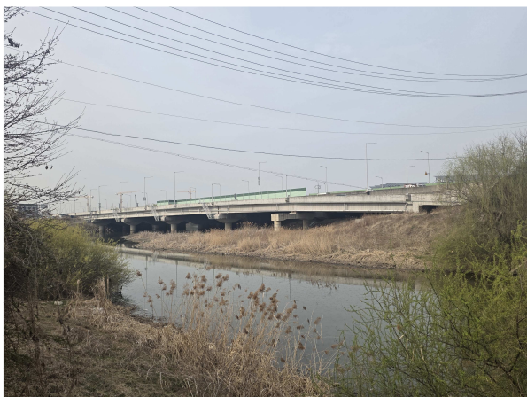
향산2교 RAMP-B교 전경
