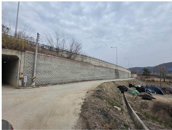
보강토옹벽(STA.2+157.750 ~2+287.500(R)) 시점부 전경
